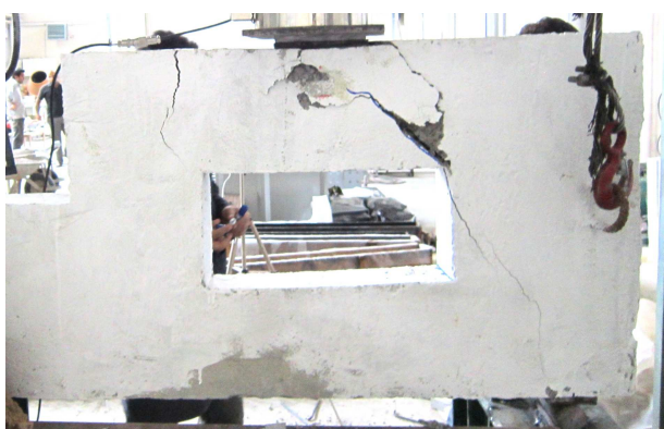
شکل ۱۷. پشت نمونه‌ی RC#۱ پس از ترک خوردگی.
