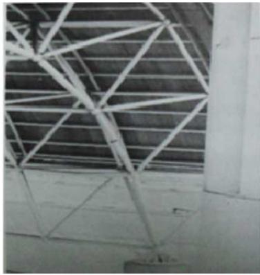
شکل ۱۰. عضو خرپای شکسته شده‌ی نزدیک تکیه‌گاه.
