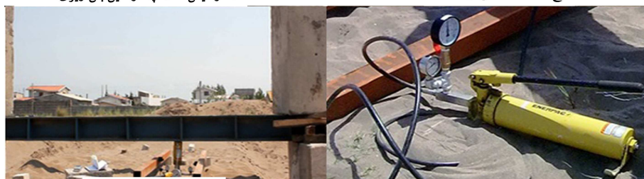
(ه) تجهیزات لازم جهت بارگذاری شمع؛
