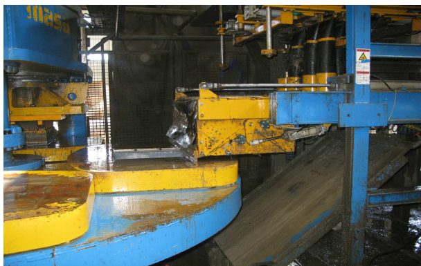
شکل ۳. ریختن بتن با اسلامپ بالا در قالب.
