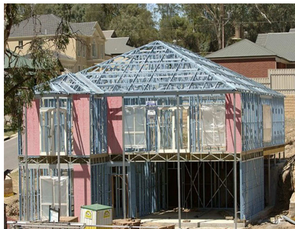
شکل ۱. قاب فولادی سرد نورد شده با پوشش صفحه‌ی سیمان فایبری.
