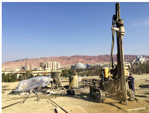
شکل ۱. اجرای انکرها در سایت پژوهشی.
