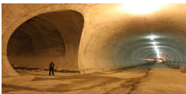
شکل ۲. تقاطع ایجاد شده در تونل حکیم.
