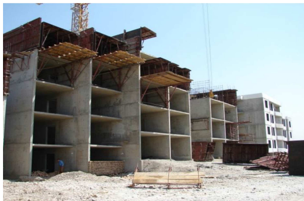
شکل ۱. نحوه‌ی قالب‌بندی ساختمان‌های قالب‌تولنی.
