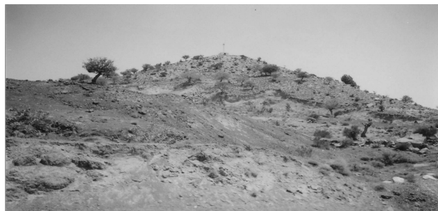
شکل ۱. نمای کلی زمین لغزش. [۳]
