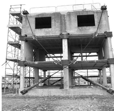
شکل ۱. مقاوم‌سازی ساختمان بتنی توسط سیستم با کابل یکپارچه به صورت خارجی.
