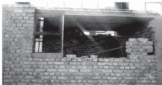
شکل ۱۲. نمای شرقی اتاق بعد از مرحله‌ی دوم آزمایش.
