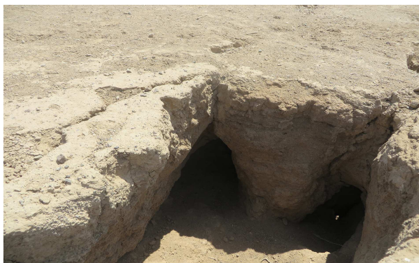
شکل ۸. نمونه‌هایی از فرسایش تونلی مشاهده شده در منطقه.
