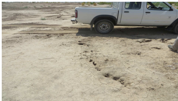
شکل ۶. نمایی از فروچاله‌های خطی در سطح زمین که نشان‌دهنده‌ی وجود یک ترک گلی در لایه‌های زیرین است.
