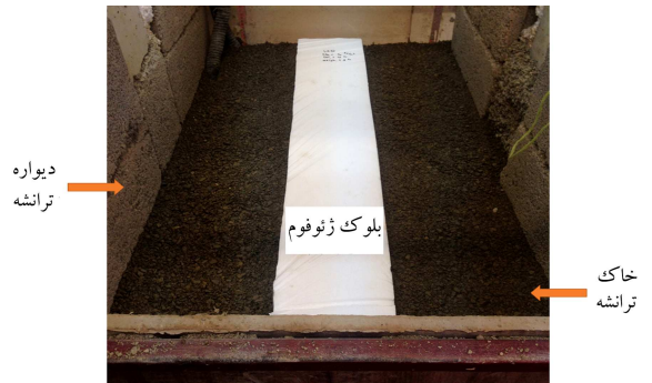
شکل ۴. تصویری از بلوک ژئوفوم واقع بر روی لوله‌ی مدفون در داخل ترانسه.
