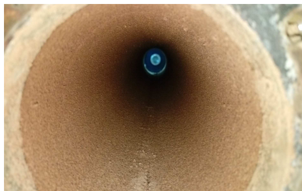
شکل ۶. چال ایجاد شده پس از خروج غلاف.
