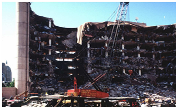
شکل ۱. نمایی از ساختمان فدرال آلفرد پی مورا اوکلاهاما. جدول ۱. تعدادی از حوادث تروریستی در دهه‌های اخیر.
