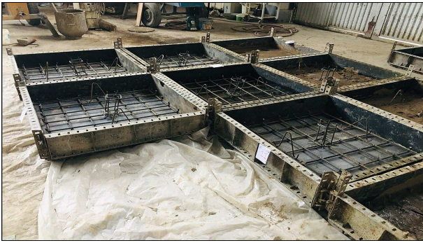
شکل ۷. قالب‌های آماده برای بتن ریزی.
