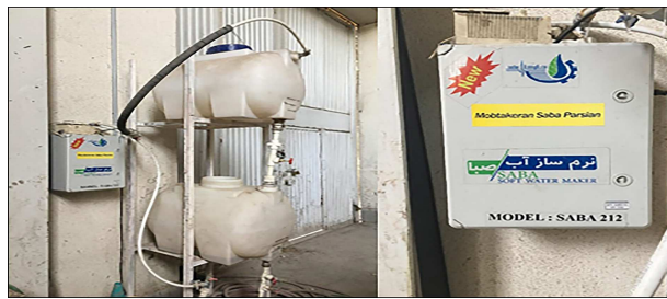
شکل ۴. دستگاه نرم‌ساز آب برای تولید آب مغناطیسی.
