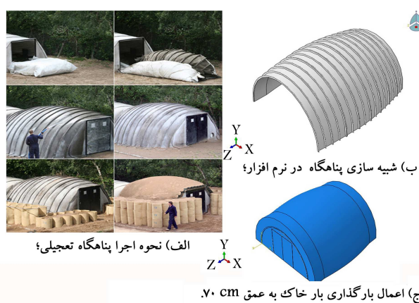
شکل ۵. پناهگاه تعجیلی بتن پارچه‌یی.
