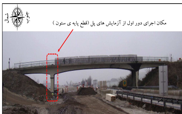
شکل ۳. نمای کناری پل S101 در حین اجرای آزمایش های آسیب شناسی. [۳۹].
