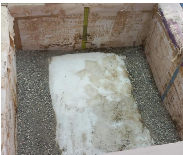
شکل ۴: تصویری از کیسه خاک در ترانشه و خاک اطراف حین آماده‌سازی ترانشه
