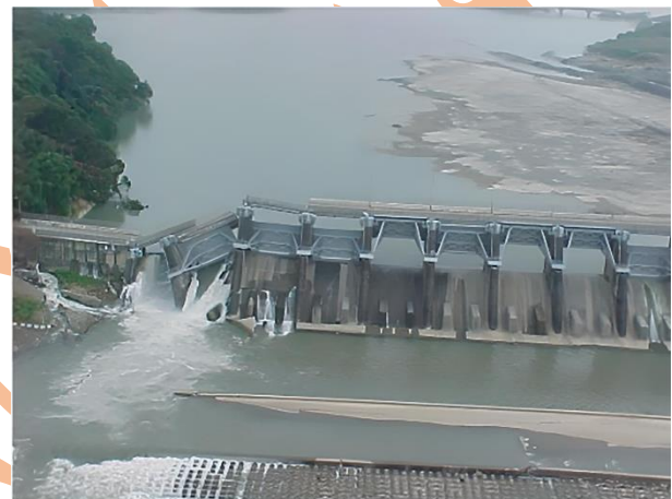
شکل ۸: تخریب سرریز بلوک‌های ۱۶ تا ۱۸ سد شی‌کانگ ناشی از زلزله چیچی در سال ۱۹۹۹
