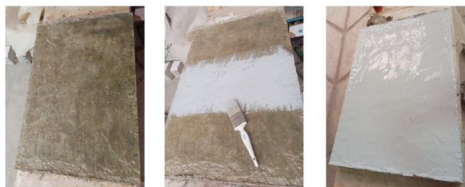
شکل ۴: نمایی دیوار W ۴ (از چپ به راست): پوشش پرایمر؛ پرداخت پوشش اصلی با قلمو، پوشش اصلی (طوسی)
