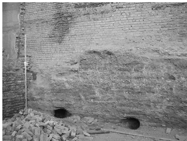
شکل ۱. نمونه‌یی از حفره‌های واقع در زیر پی ساختمان.
