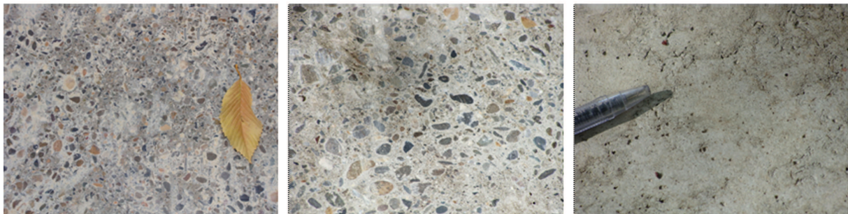
شکل ۳. وضعیت سطح بتن (به ترتیب از راست به چپ)، قبل از آماده‌سازی، پس از زدن ساب و پس از پرکردن حفره‌ها.
