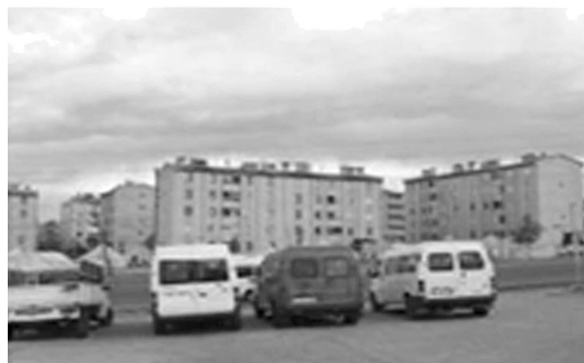
شکل ۱. نمونه‌هایی از سیستم دال و دیوار پس از زلزله‌ی Bingol (۲۰۰۳) که دچار آسیب نشده‌اند.
