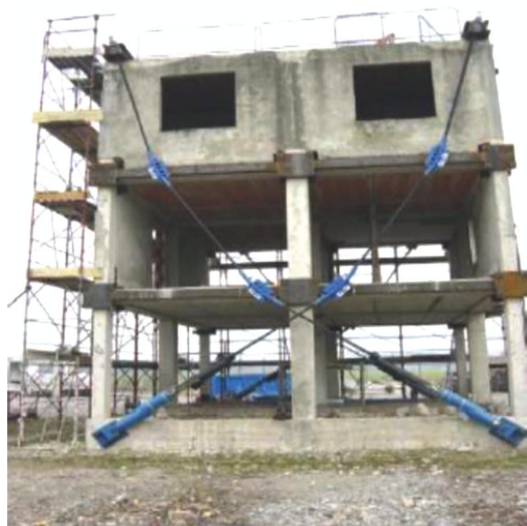
شکل ۱. ساختمان ساخته شده جهت مقاوم‌سازی با سیستم کابلی در پروژه‌ی تحقیقاتی SPIDER. [۷]
