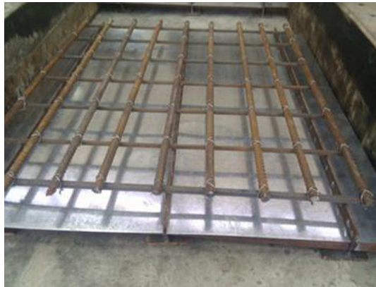
شکل ۹. عرشه‌ی اگزودرمیک آماده‌ی بتن‌ریزی.
