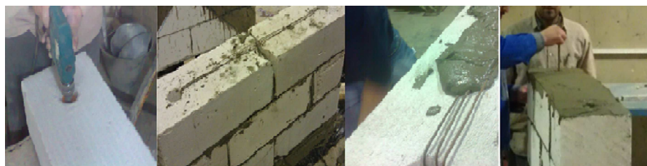
شکل ۴. نحوه‌ی تسلیح عمودی و افقی دیوارها.
