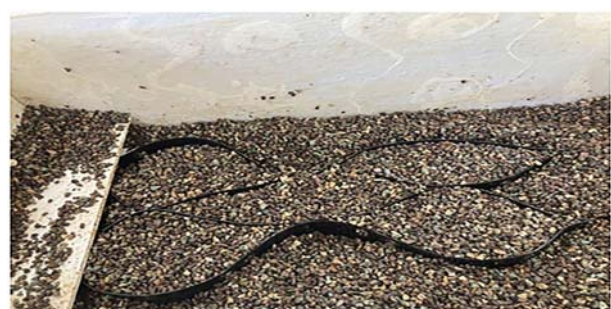
شکل ۸. ژئوسل پر شده از مصالح دانه‌یی.
