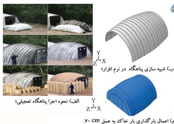
شکل ۵. پناهگاه تعجیلی بتن پارچه‌ای.
